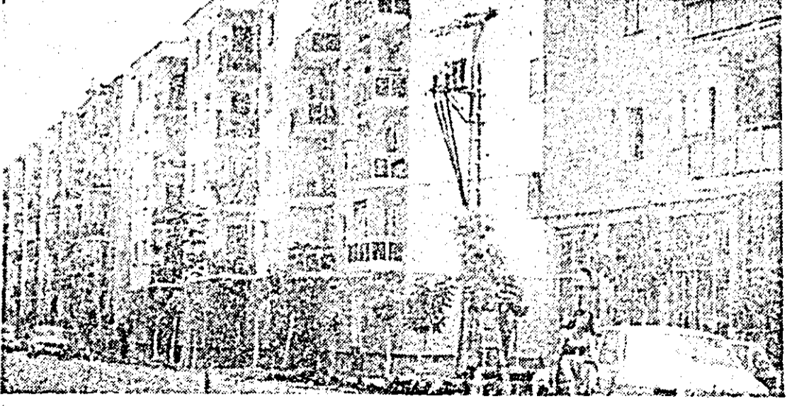
Noile blocuri de locuințe — expresie clocventă a prefacerilor edilitare.
