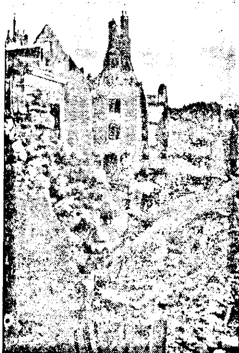
Zerstörte Häuser in Courtenay
