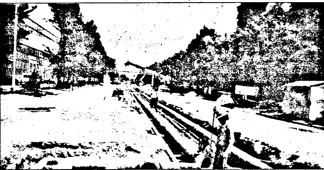
Aspect de pe șantierul magistralui CET aflată acum, în fază de închidere a canalului tehnic. În jurul datei de 15 septembrie este prevăzută redeschiderea traficului auto. Se zice despre particulari că obișnuiesc să-și țină cuvântul, mai ales atunci când l-au pronunțat în prezența unor ziarști.
