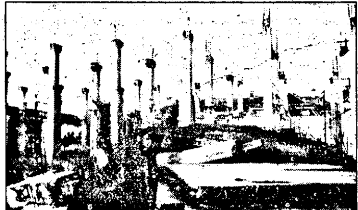
În urmă cu 10 ani, la Pâncota s-a început construirea unui hotel. În lipsa banilor, lucrările au rămas în stadiul de față...
