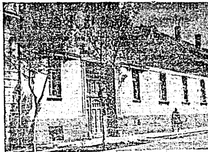
Sediul Consiliului Național Român Central (Arad, strada 6 Martie nr. 3).
