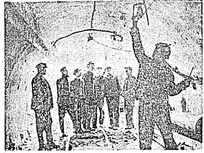
În 1931 mina Dilja din Petroșani, exploatață națională, a fost lăsată ca nerentabilă. Sute de milioane, lăsați pe drumuri, au îngroșat atunci rândurile pomerilor. Azi, a ceeașă mină a reînceput o viață nouă. Vechiile galerii sunt curățate, armate din nou, mină este dotată cu utilaj modern. Pe măsură ce mină se înălță înaltează în muncă de refacere a galerilor, electricienii pun la punct instalările de iluminare și cele de alimentare a locomotivelor electrice.
