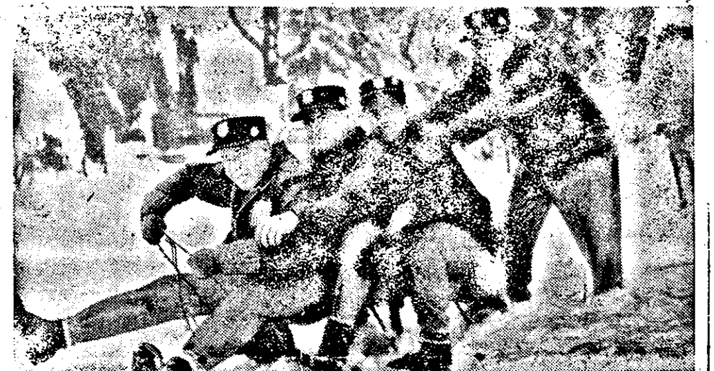
Die amerikanische Mannschaft im Bierschneebob ist bereits in Garmisch-Partenkirchen eingetroffen und trainiert hier zunächst einmal auf einem Kindererlisler.
