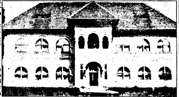
Cochetul sediu al Fabricii de fermentare a tutunului din Arad, imobil construit în anul 1848.
