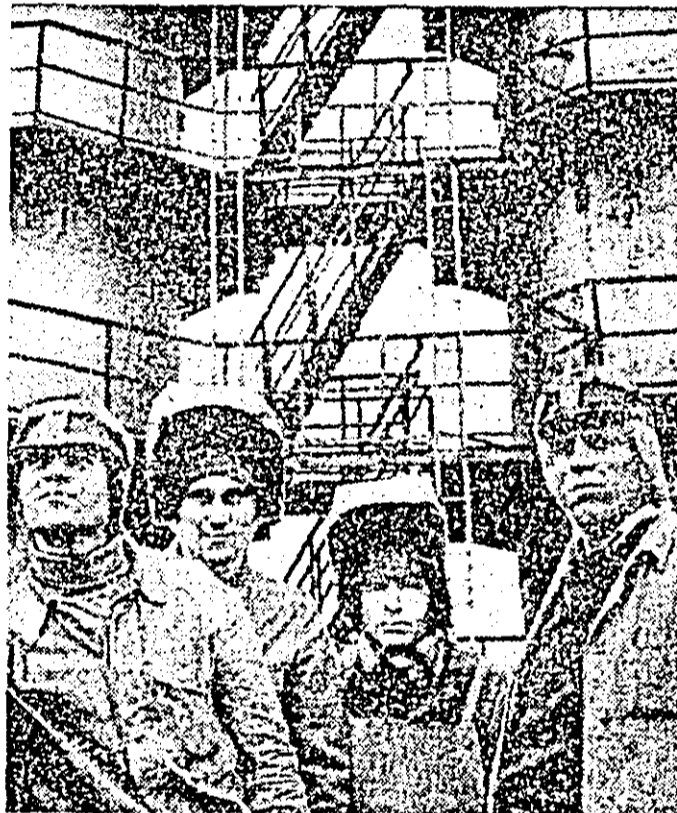
Pe platforma industrială din nord-vestul municipiului, noile obiective economice poartă amprenta hărniciei constructorilor arădeni. Foto: M. CANCIU
