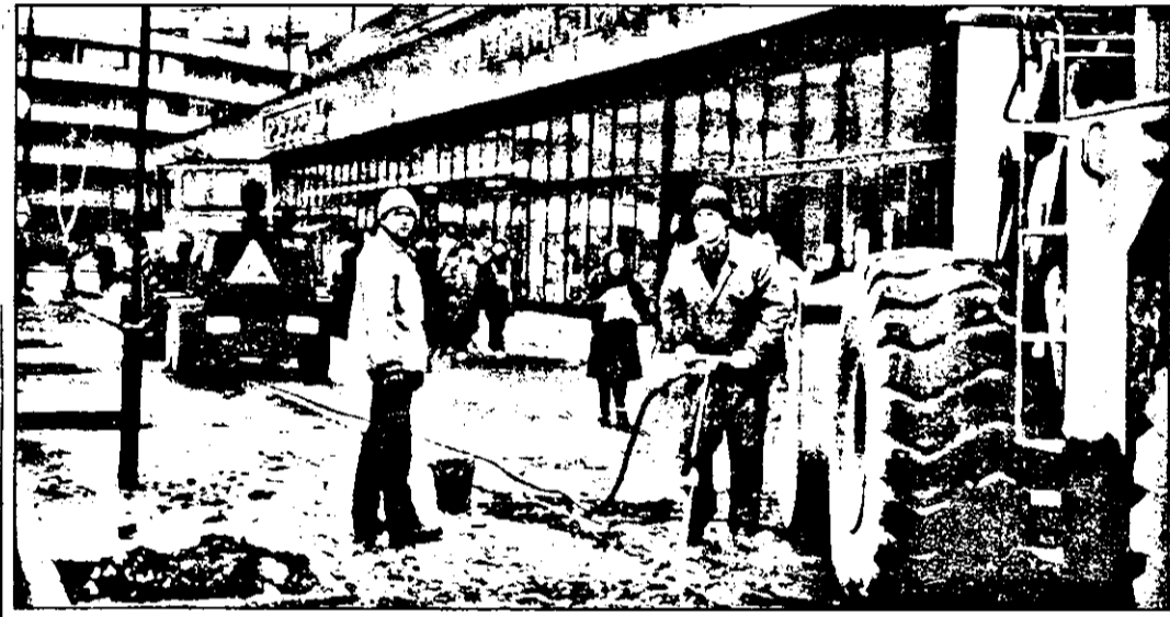
Semne de primăvară și la propriu și la figurat în zona Gării CFR Arad: se lucrează la decopertarea asfaltului degradat de pe trotuar și turnarea unui nou covor asfaltic.
