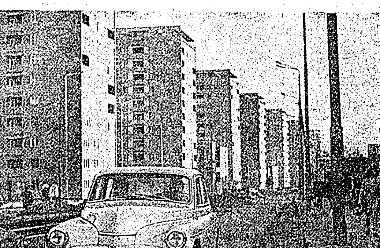
Calea Romanilor, șantier al importanțelor lucrări edificat-gospodăresci ce se efectuează în municipiul nostru, va fi una dintre cele mai moderne artere ale Aradului.
