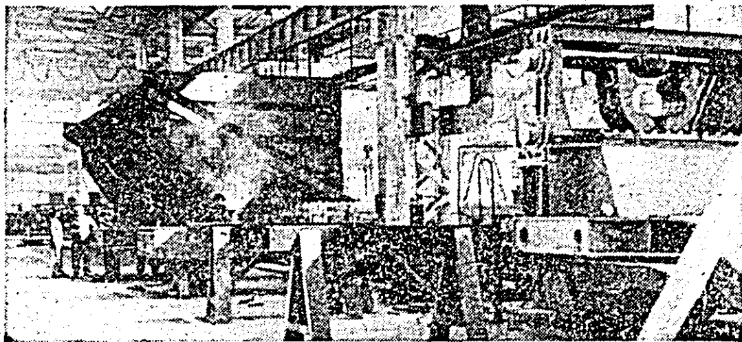
Întreprinderea de vagoane. Aspect de muncă în hala de montaj utilaj tehnologic.
