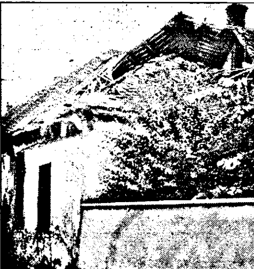
Afiată într-o stare avansată de degradare, clădirea ce adăpostește Poșta din Sâncolau Mic, în urma furtunii de marți seara, a fost avariata cu totul
