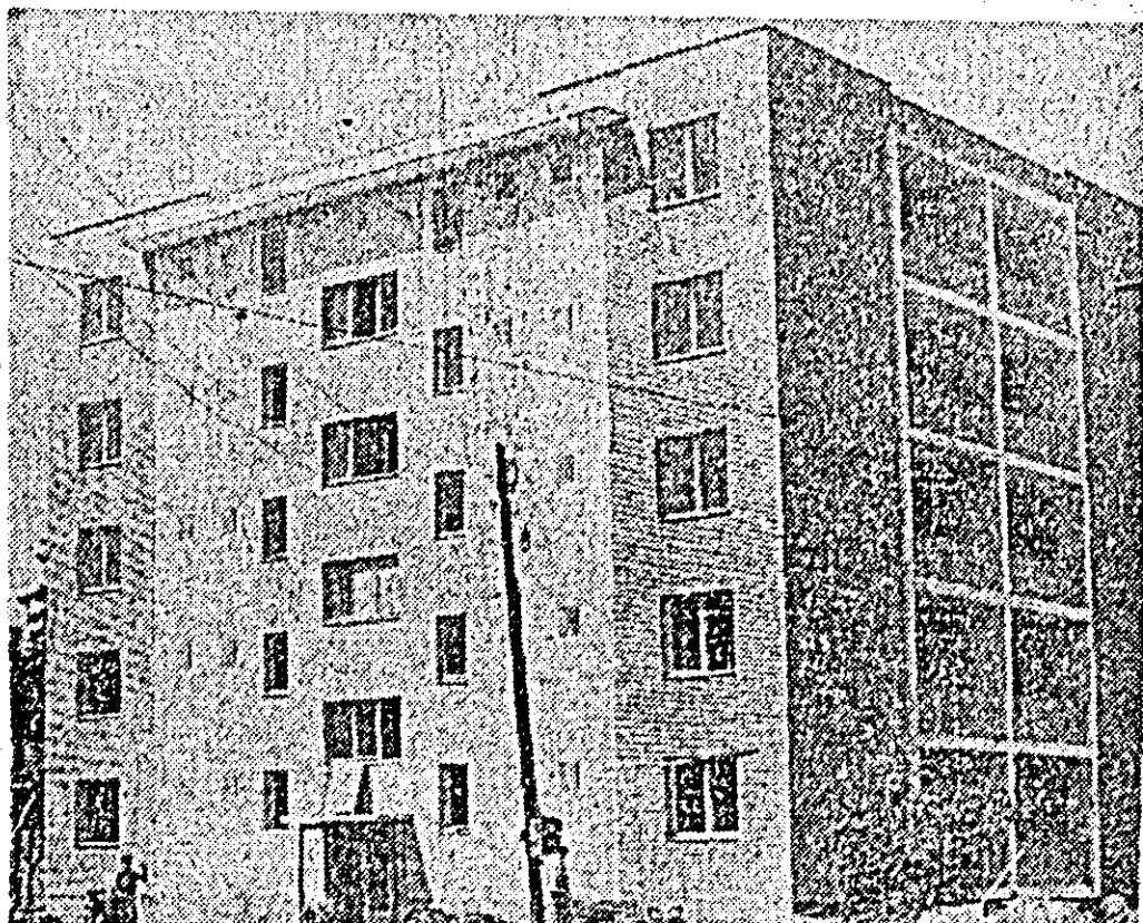
Blocul B din zona Lacului, executat de Truștul 4 construcții Arad, este gata să-și primească locatarii cu 30 zile mai devreme.
