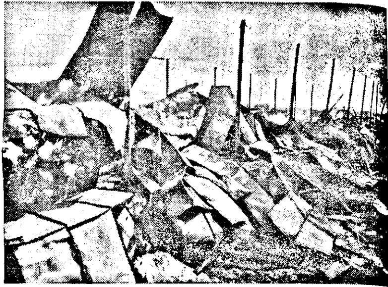
Eine völlig zerstörte Flugzeugfabrik vor Kiew.
