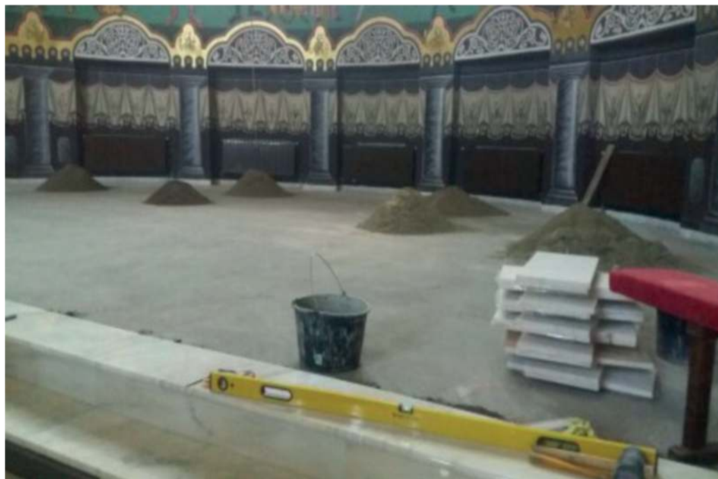
Lucrări la pardoseala Catedralei (2018)
