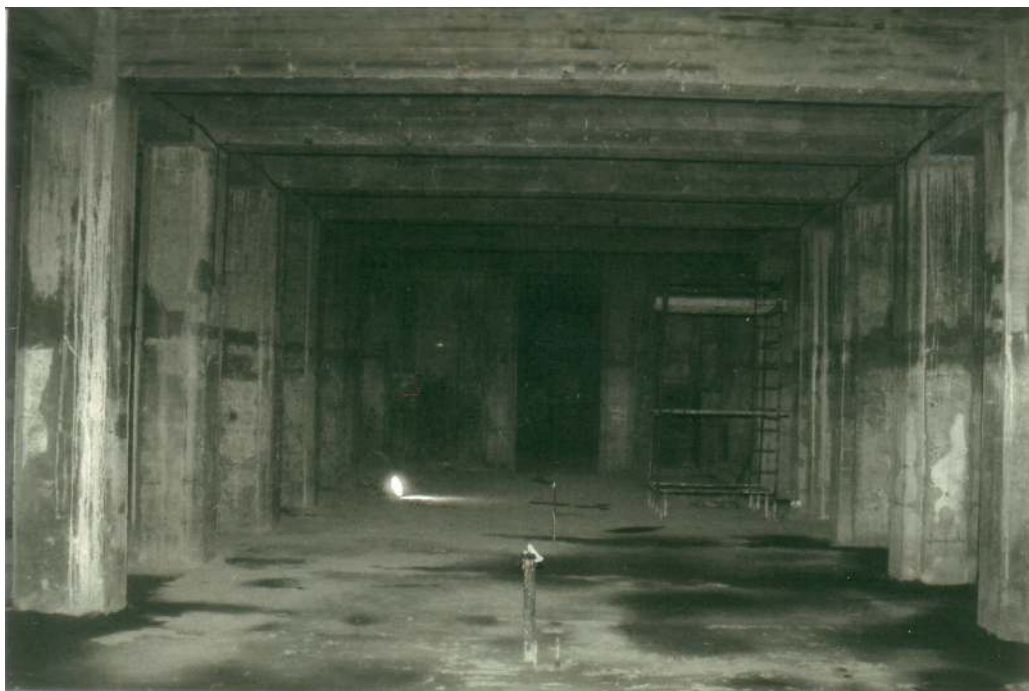
Demisolul Catedralei - structură de rezistență (1995)
