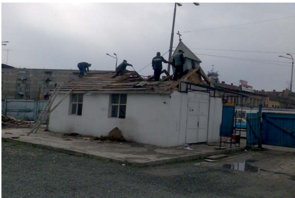
Demolarea Paraclisului din șantierul Catedralei (2008)
