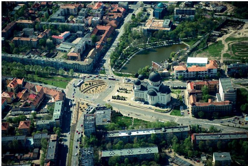
Catedrala Arhiepiscopală „Sfânta Treime” - vedere aeriană
