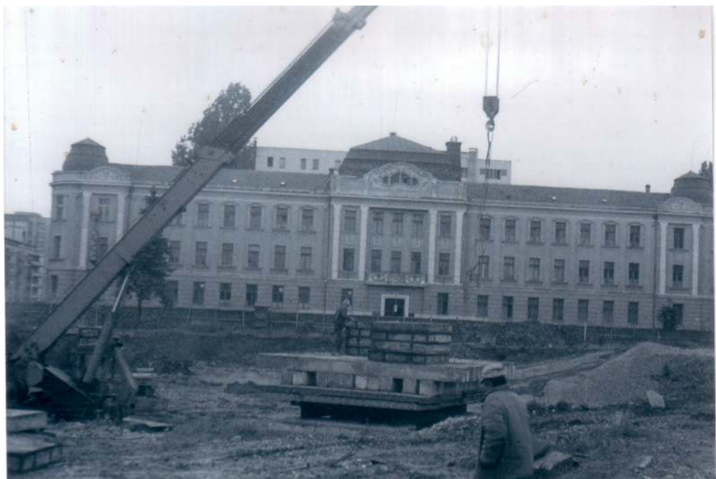
Pregătirea terenului de fundare (1992)
