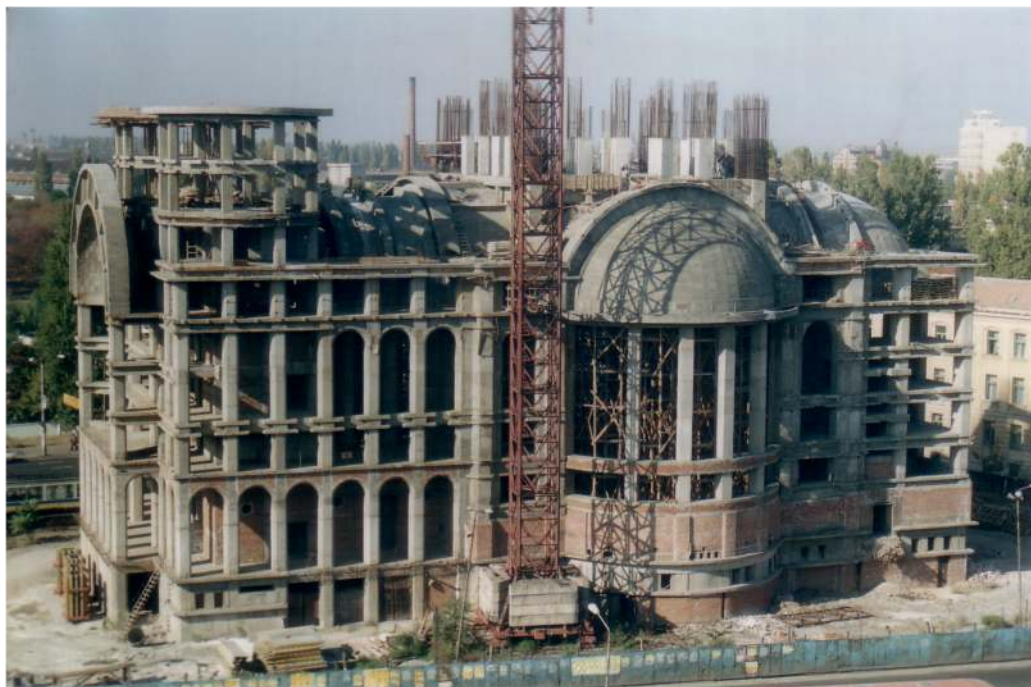
Construcția la nivelul cupolelor (2005)
