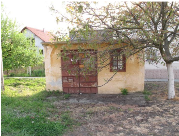
Stația de tramvai - Miniș-Primărie
