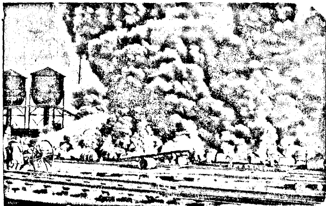
Auf dem Bahnhof Kearney der Pennsylvaniaabahn im Staate New Jersey gerieten kürzlich mehrere Ölfabrikwagen in Brand. Das Feuer griff auf die
