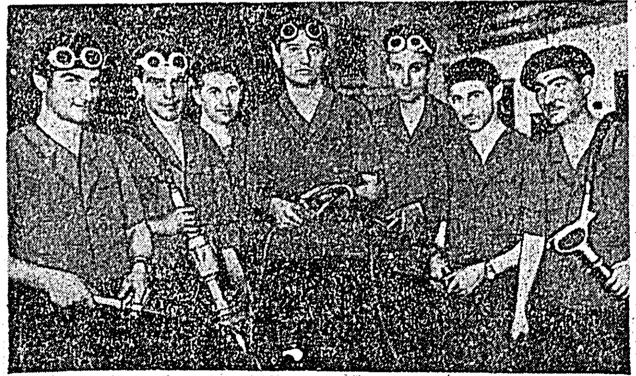
Continuînd și rul succesorilor obținute, brigada de lăcătuși și sudori autogeni condusă de Trajan Drăgan din secția de montaj sudură a Uzinelor de vagoane obține frumoase realizări în producție. Numai în luna trecută membrii acestei brigăzi au făcut peste plan lucrările la trei vagoane și o economie lit de electrozi și oxigen în valoare de 2.455 lei. Însemnate realizări au obținut membrii brigăzii condusă de Trajan Drăgan și în cursul lunii august.
