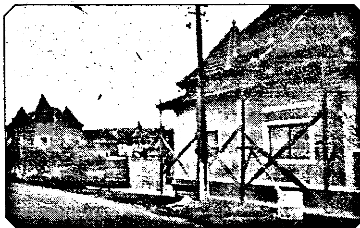
Dacă unii dintre proprietari, din diverse motive, au fost nevoiți să abandoneze lucrările, la unele dintre case se efectuează ultimele finisări
