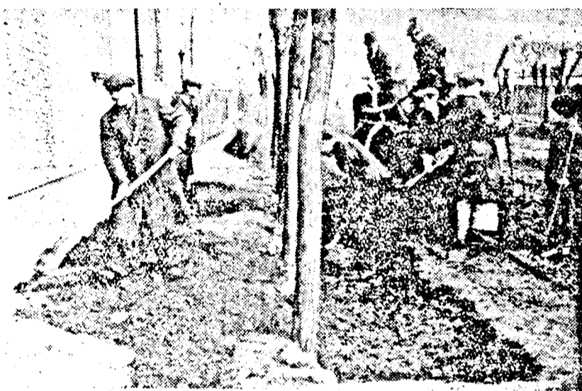
Prin muncă voluntară locuitorii din cartierul Grădiște își repară drumurile.
