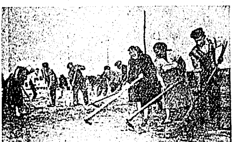
Deputatul Paul Petru din circumscripția orășenească nr. 36 a mobilizat numeroși cetățeni în diferite acțiuni de folos obșteac. Clîșeul reprezintă un grup de cetățeni lucrînd la reparatul străzii Tîrgului.
