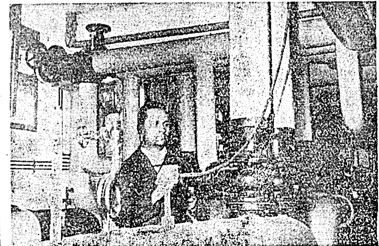
Punctul termic nr. 8 asigură căldura necesară blocurilor din străzile Grigorescu, Praporgescu și Statului popor arădeanesc. Iată în cîșcul nostru pe fochistul termic Simion Bolchiș verificînd funcționarea aparatelor de distribuție a căldurii.
