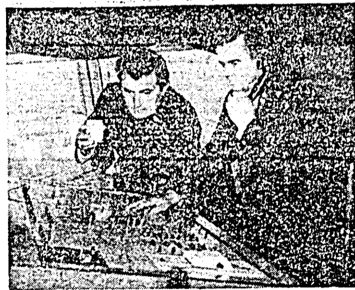
Procesul de modernizare a stației C.F.R. Arad a fost extins și la cocoșa de triere, manevrarea făcîndu-se acum automat prin instalații cu rele. ÎN FOTOGRAFIE: operatorii Ioan Pop și Gh. Babău lucrînd la masa automată de manevră.
