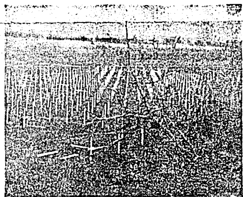
Sectorul legumicol al I.A.S. Fintinele se extinde an de an. Astfel, serele-solar vor mai ocupa anul acesta încă 8 hectare. ÎN IMAGINE: aspect de la plantarea stîlpilor din beton pentru solar. Foto: V. MOTOCEA
