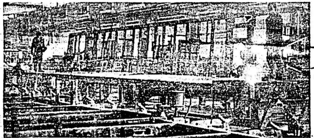
Secvență cotidiană de muncă la întreprinderea de vagoane. Se acționează intens pentru realizarea sarcinilor în atelierul de montaj-sudură. Foto: M. CANCIU
