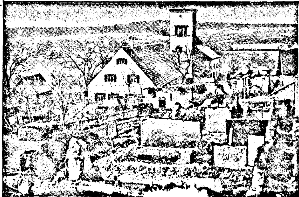
7 Wohnhäuser durch Brandstiftung zerstört. Uebersichtsbild von der Brandstätte.
