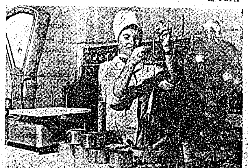
Laboratorul fabricii „Refacerea” Arad. Aici se execută probe pentru stabilirea acidității, a conținutului de sare cît și a gramajului corespunzător.
