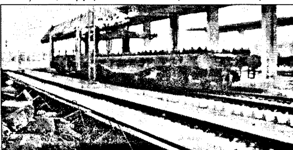
Lucrarea cea mai complexă, montarea liniilor ferate 1 și 2 peron, pe o lungime de 700 m, a fost deja făcută. După operațiile de aducere la cotă a liniilor, trenurile vor putea circula normal.
