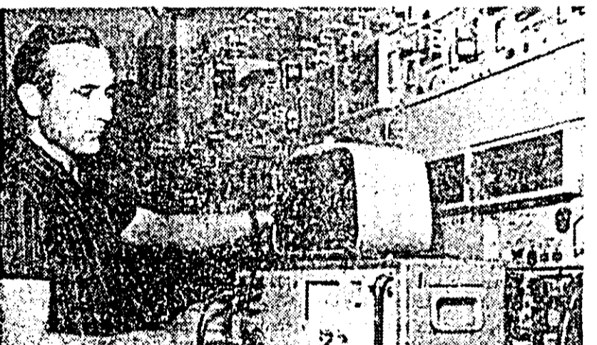
Șeful de tură Nicolae Bădără de la centrala telefonică Arad execută măsurători la sistemele de curenți purtători cu 12 căi, asigurînd buna funcționare a centralei.
