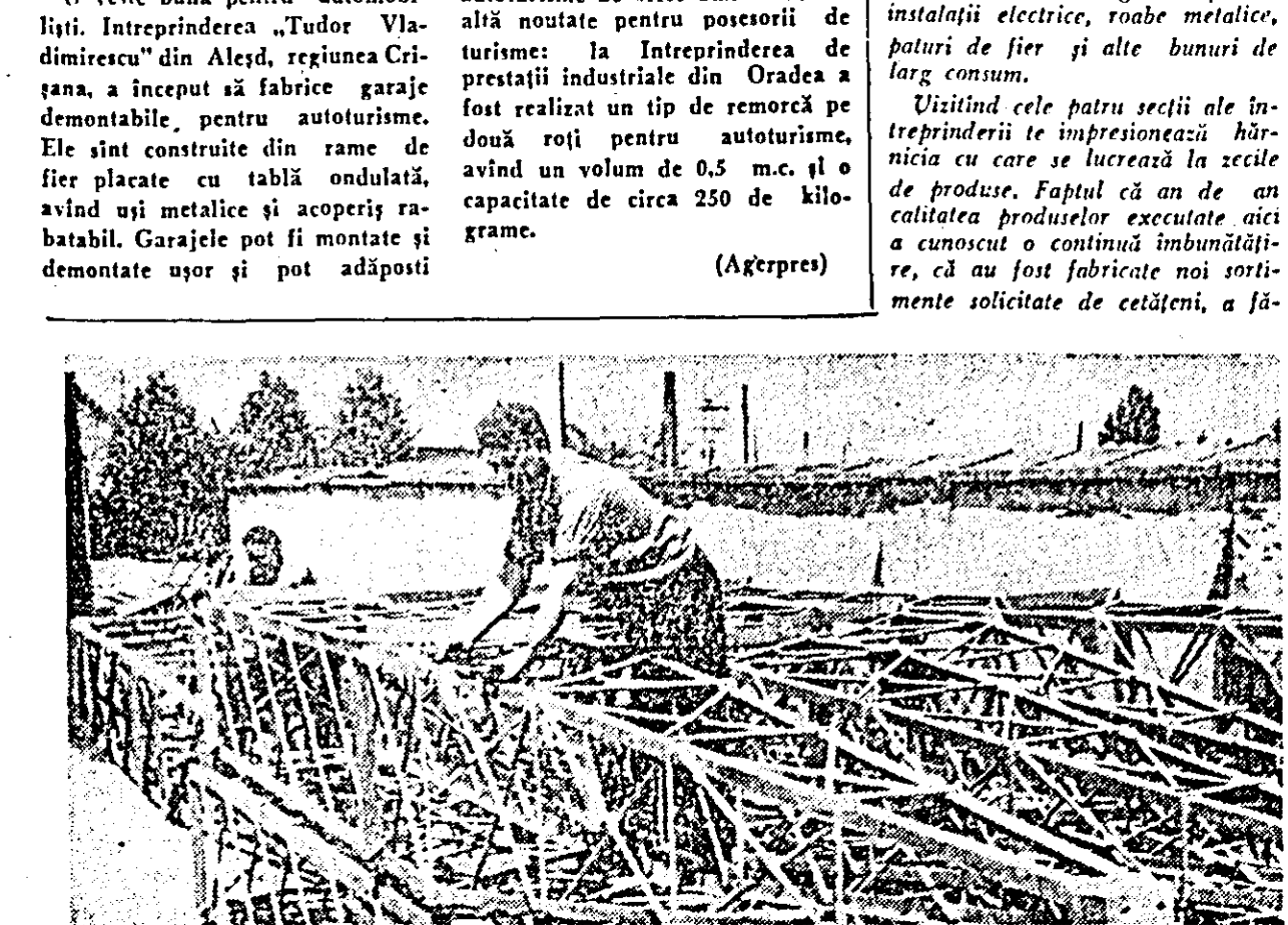
Aspect de lucru de la secția a III-a a Întreprinderii regionale „Electrometal”. Tovarășii Sebastian Tumele și Mihai Frer fac ultimele verificări la un nou lot de produse gata să ia drumul beneficiarilor.
