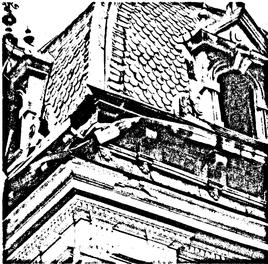
Acoperișul de unde se pot desprinde, oricând, bucăți de ornamente sau țigle
