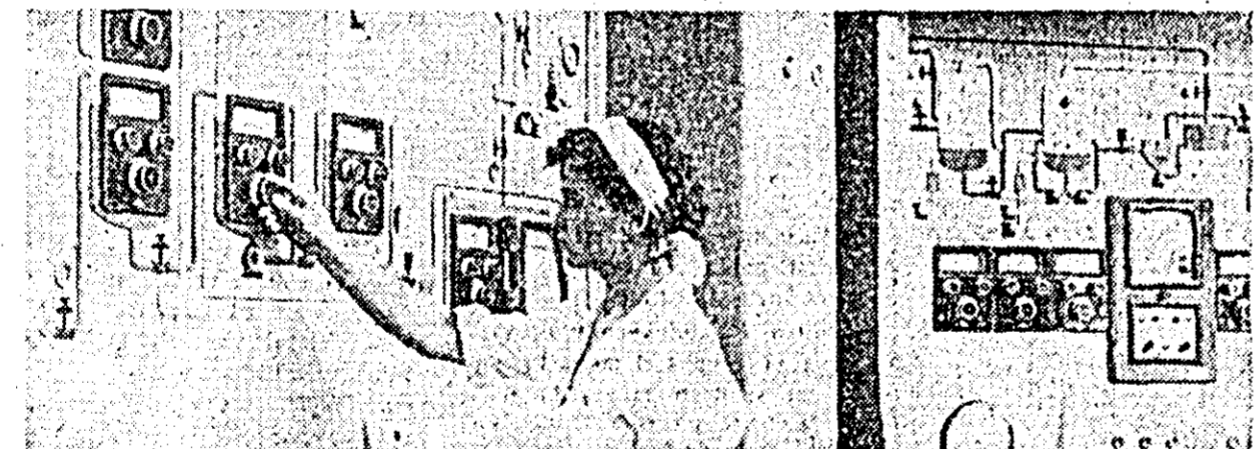
Fabrica „Refacerea”: La panoul de comandă tovarășa Florica Clonca urmărește cu atenție funcționarea agregatelor.
