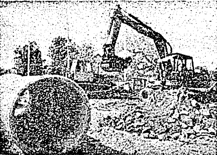
Concomitent cu construirea noului linii de tramvai, pe strada Renașterii, au început lucrările de instalare a conductelor care va alimenta cu apă potabilă zonele de locuințe din Micăla-ca și Subcetate. Lucrările sînt executate de șantiierul I.J.G.C.L. Arad.
