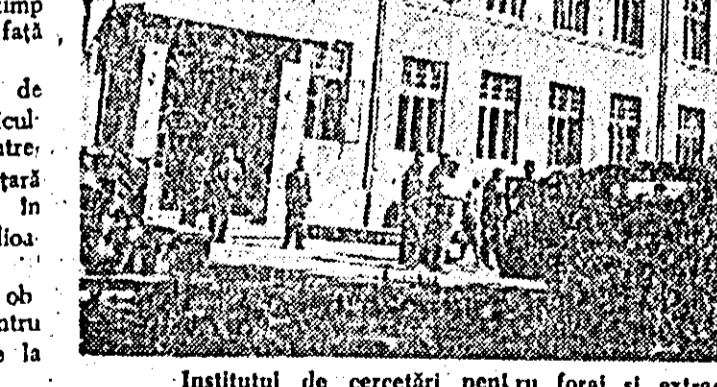
Institutul de cercetări pentru foraj şi extracţie din Cimpina.
