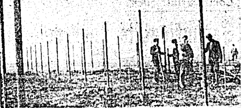
Dezvoltarea legumiculturii este asigurată la cooperativa agricolă de producție din Sintana prin efectuarea unor importante lucrări de investiții. ÎN CLISEU; se lucrează la construirea unei noi sere solare.
