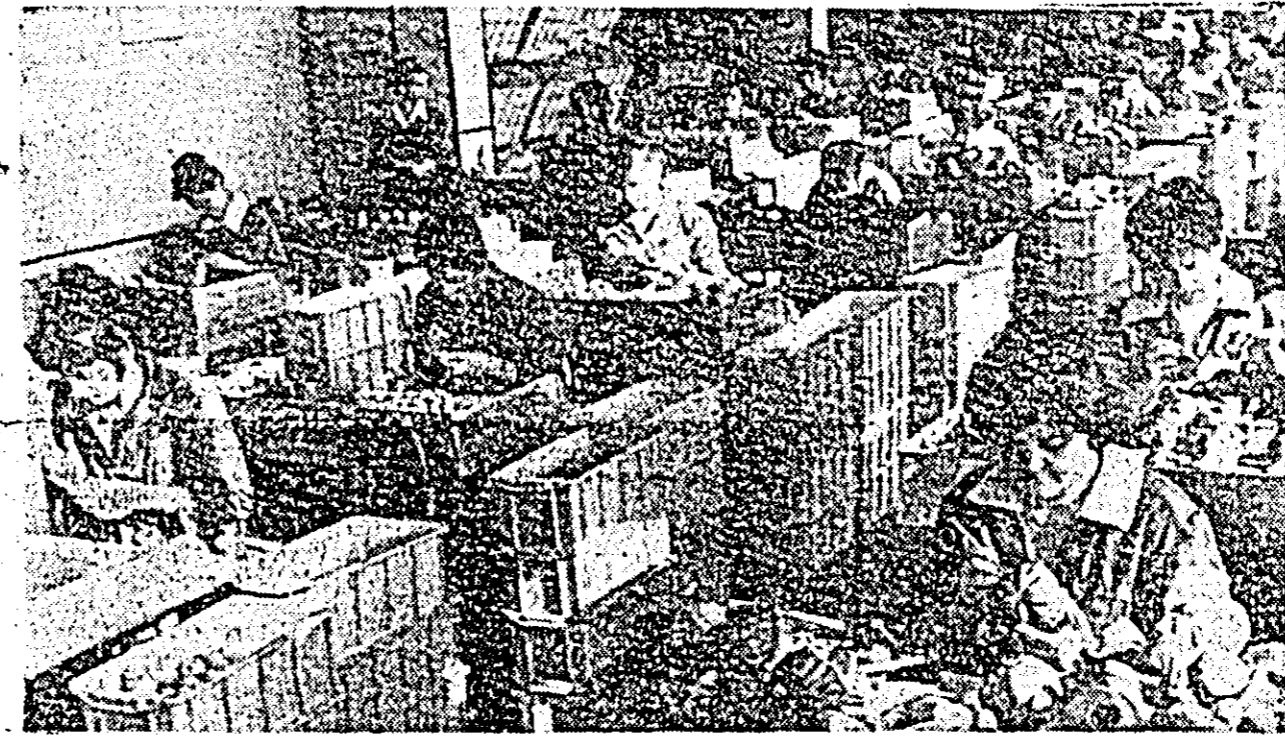
Fabrica de păpuși „Arădeanca”, secția plectat. Aici se nasc zimbetul și drăgălășenia păpușilor.
