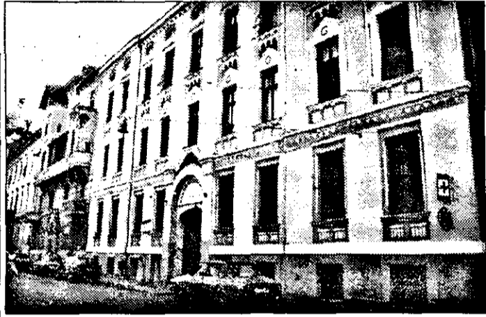
(Doar) fațada Spitalului Matern
