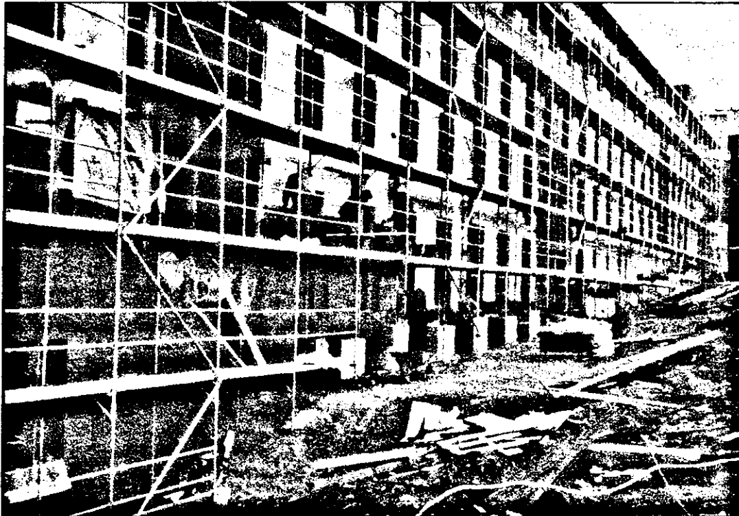
Un obiectiv de construcții al firmei „D.R.G.”, la care participă și constructori arădeni: Academia de finanțe din Bruhl-Köln.
