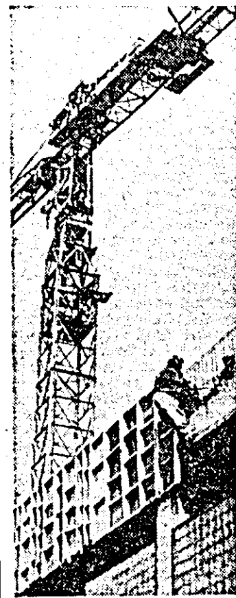
La înălțime... (construcții pe șantierul platformei industriale alimentare Arad).
