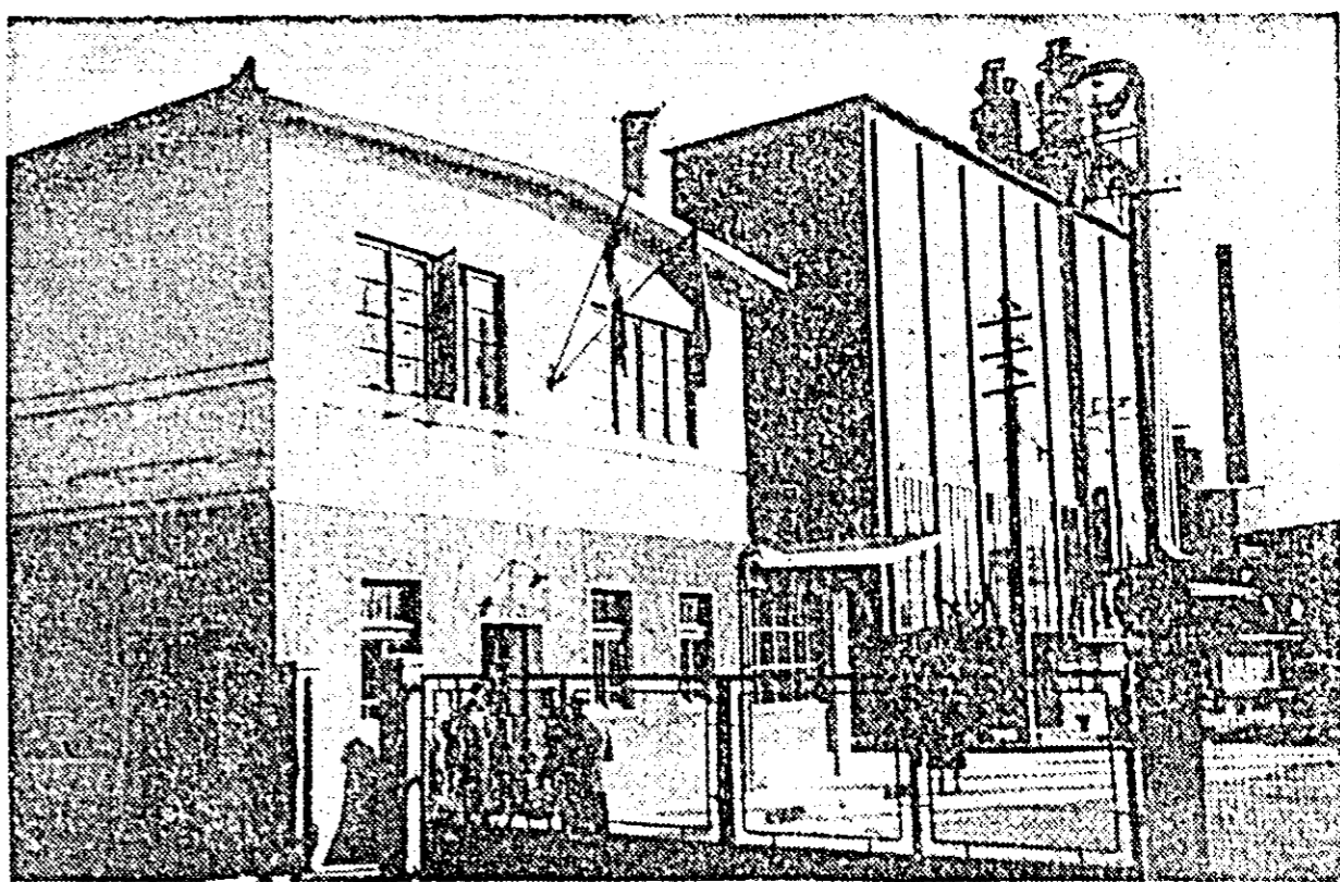
Fabrica IPROFIL „Răsăritul” din Pincota a luat în ultimii ani o împetuoasă dezvoltare. Hale, ateliere și instalații noi asigură azi constructorilor de mobilă condiții tot mai bune de muncă. ÎN FOTOGRAFIE: aspect al fabricii IPROFIL „Răsăritul” din Pincota.
