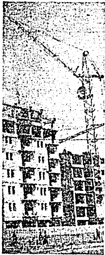
În construcție, noi blocuri de locuințe în zona Căii Aurel Vlaicu.
