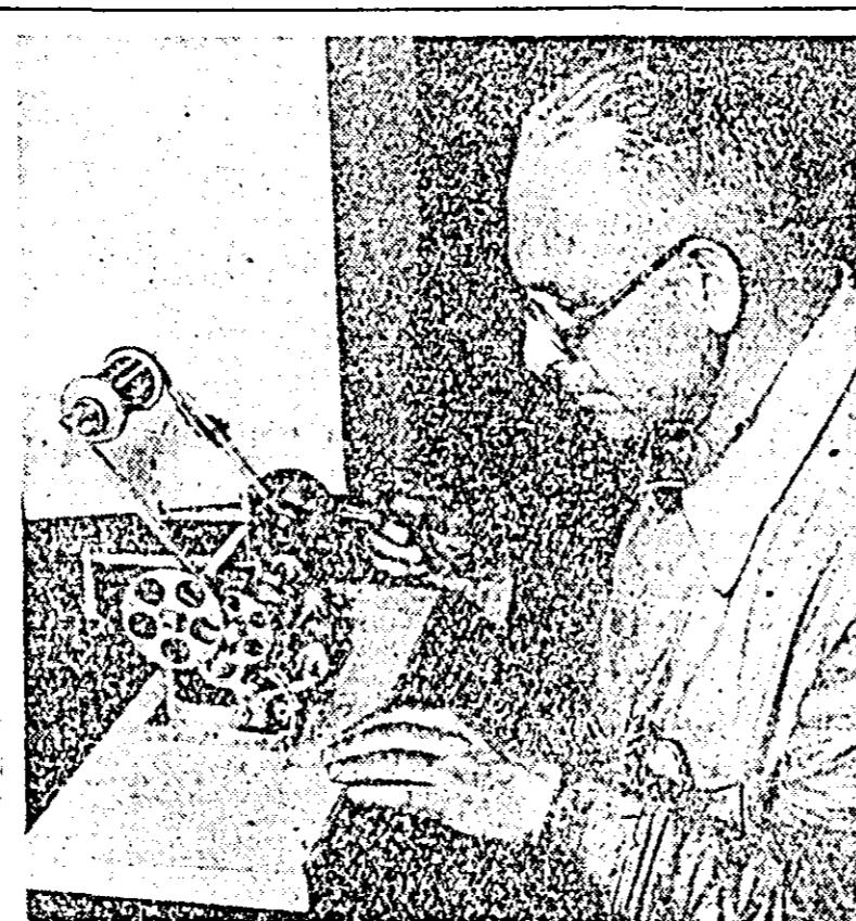
Cunoștința inovator din Dapolul de automotoare, mașinistul Teodor Tentzlinger a realizat recent o mașină pentru bobinat termocimentă la automotoare. Prin aceasta se poate bobina un fir subțire de 0.03 mm, mai subțire ca firul de par. În cizme: mașinistul Tentzlinger face ultima încercare a mașinii construită de el.
