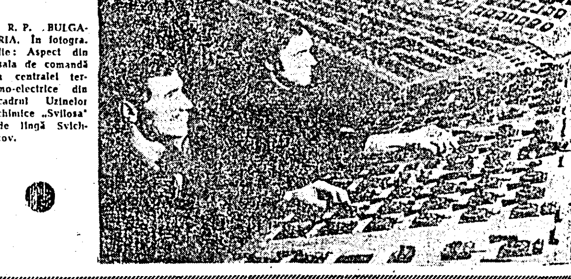
R. P. BULGARIA. În fotografia: Aspect din sala de comandă a centralei termoelectrice din cadrul Uzinelor chimice „Svilosa” de lângă Svich-tov.
