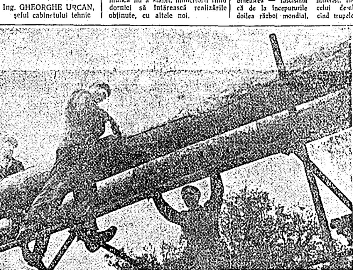
Tovarășii Petru Ilincău, Nicolae Oancea și Petru Dărăban, sînt trei muncitorii evidențiați din echipa de izolatori a șantierului de termoficare. Ei își depășesc mereu planul cu 20—25 la sută, executînd lucrări de cea mai bună calitate.
