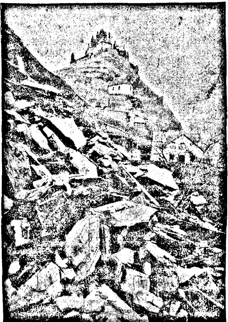
Im Hintergrund Burg Cochem an der Mosel. Der Berggrutsch bei Cochem dauert nunmehr bereits 2 Jahre lang. Täglich wandert der Berg einige Zentimeter abwärts und ein Teil der Ortschaft muß als verloren gelten.
