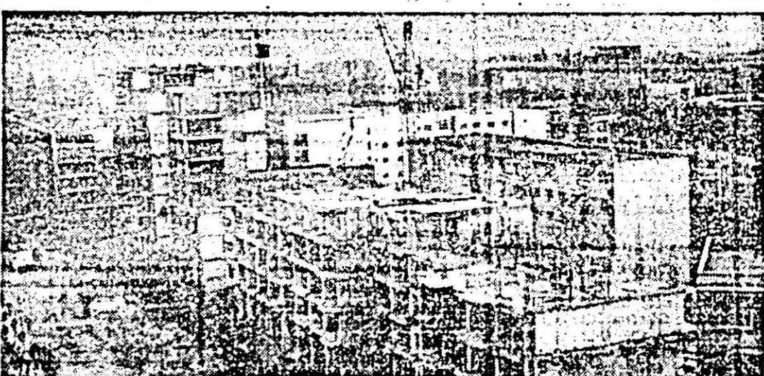
În construcție, noi blocuri de locuințe în zona întreprinderii „Tricolor roșu”.
