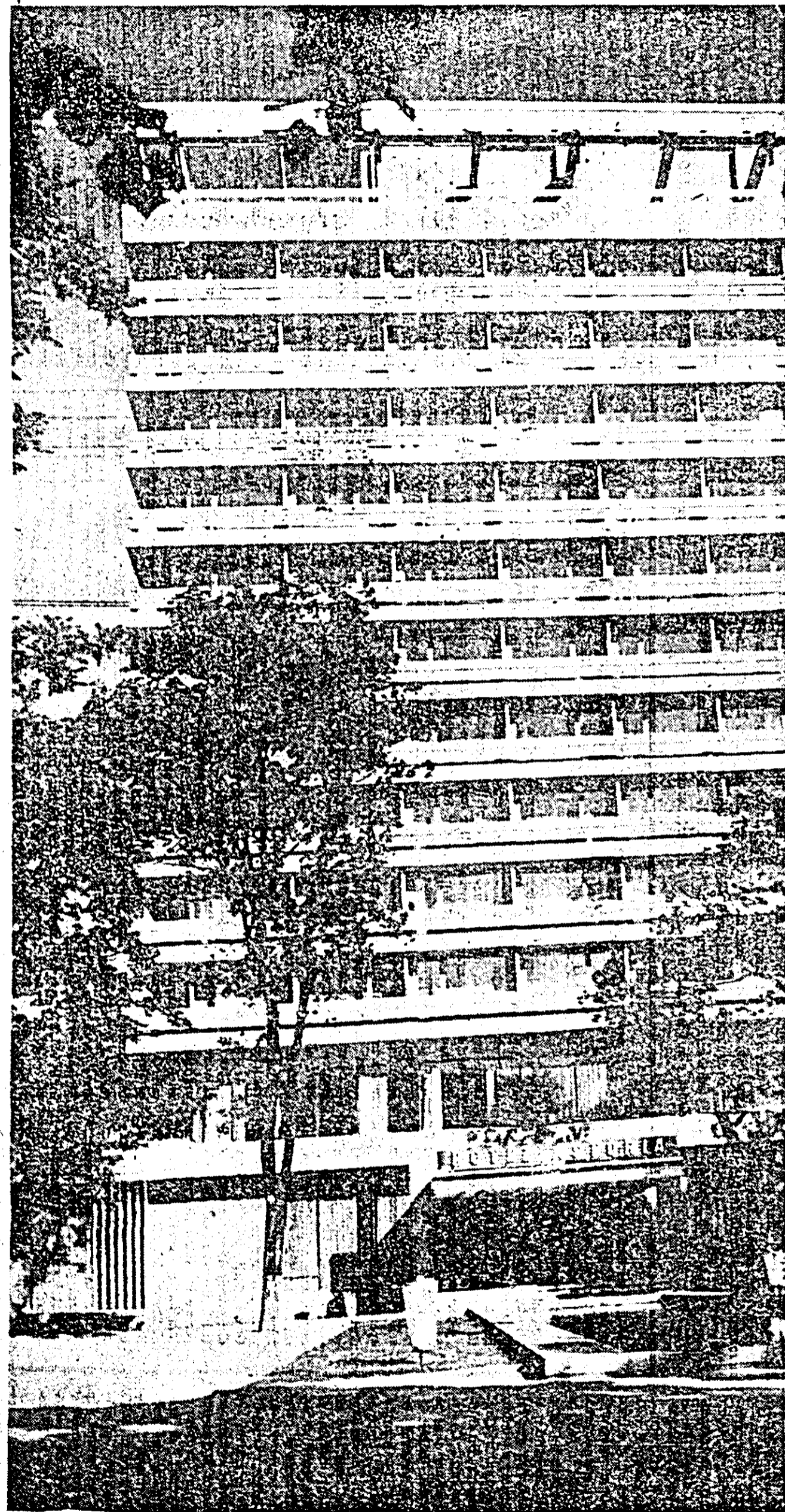
HOTELUL ASTORIA — una din construcțiile moderne ale noului peisaj arădan.
