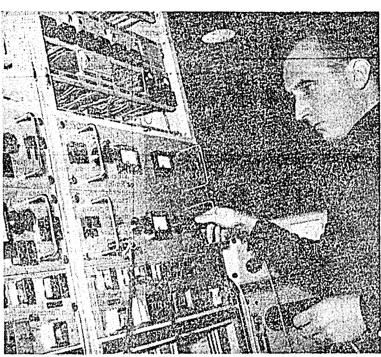
Electromecanicul principal Nicolae Bădrugă urmărește funcționarea noului sistem de cureni purtători cu tranzistori, cu care a fost dotat de curînd sectorul tehnic al centralei telefonice din orașul nostru.
