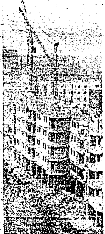
Arad, în construcție, noi blocuri de locuințe. Foto: AL. MARIANUT
